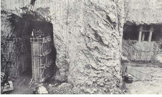
Keban Barajı İnşaatı
