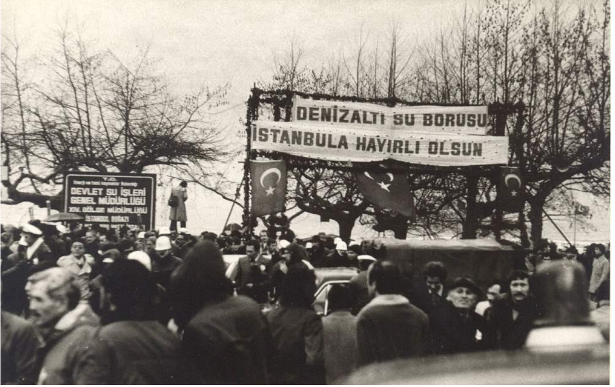
İstanbul Su Siteminde " Denizaltı Su Borusu" tesisinin açılışı
