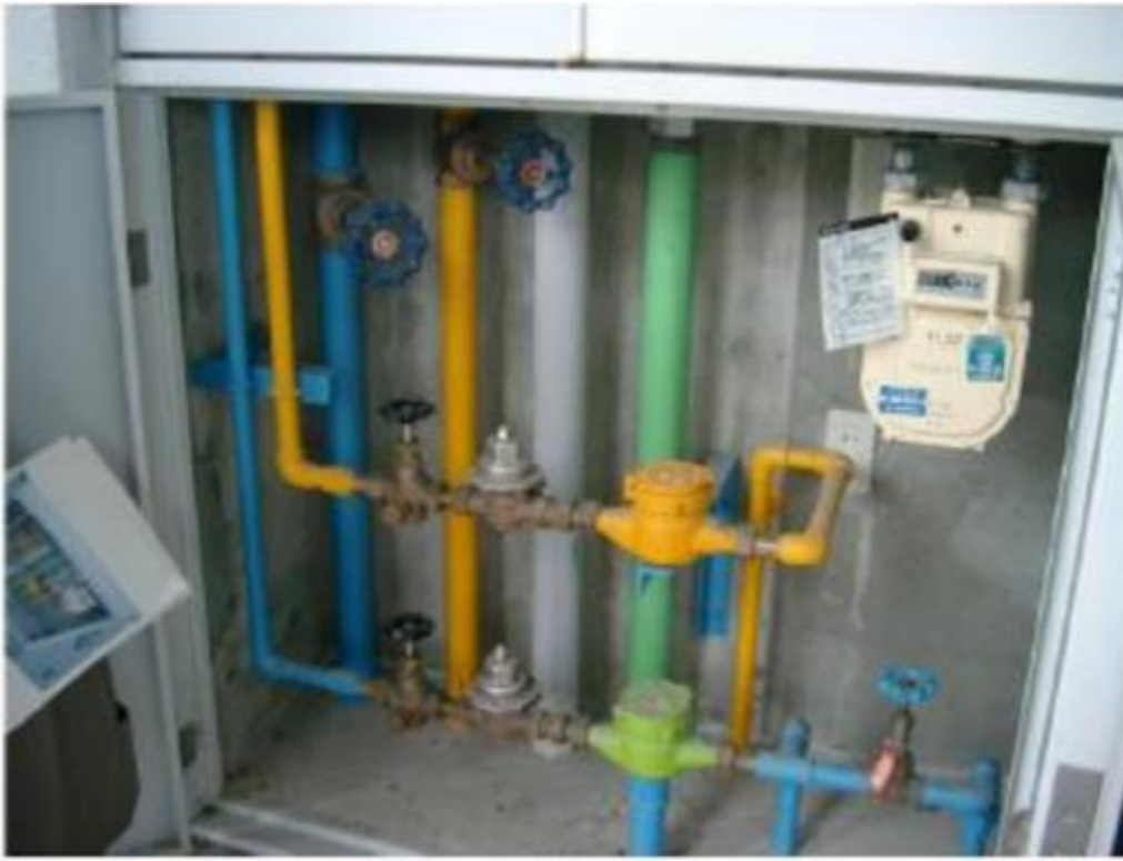
Şekil 6. Japonya'da çoklu dağıtım hatlarının ayırt edilmesi için renklerin kullanımı; burada mavi hat içme suyu sarı hat ise arıtılmış atıksu hattıdır (11)
