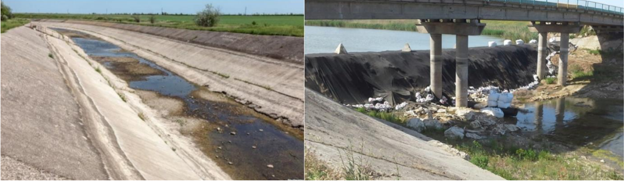
Şekil 2. Kuzey Kırım Kanalı ve suyun geçişini engelleme yapısı
