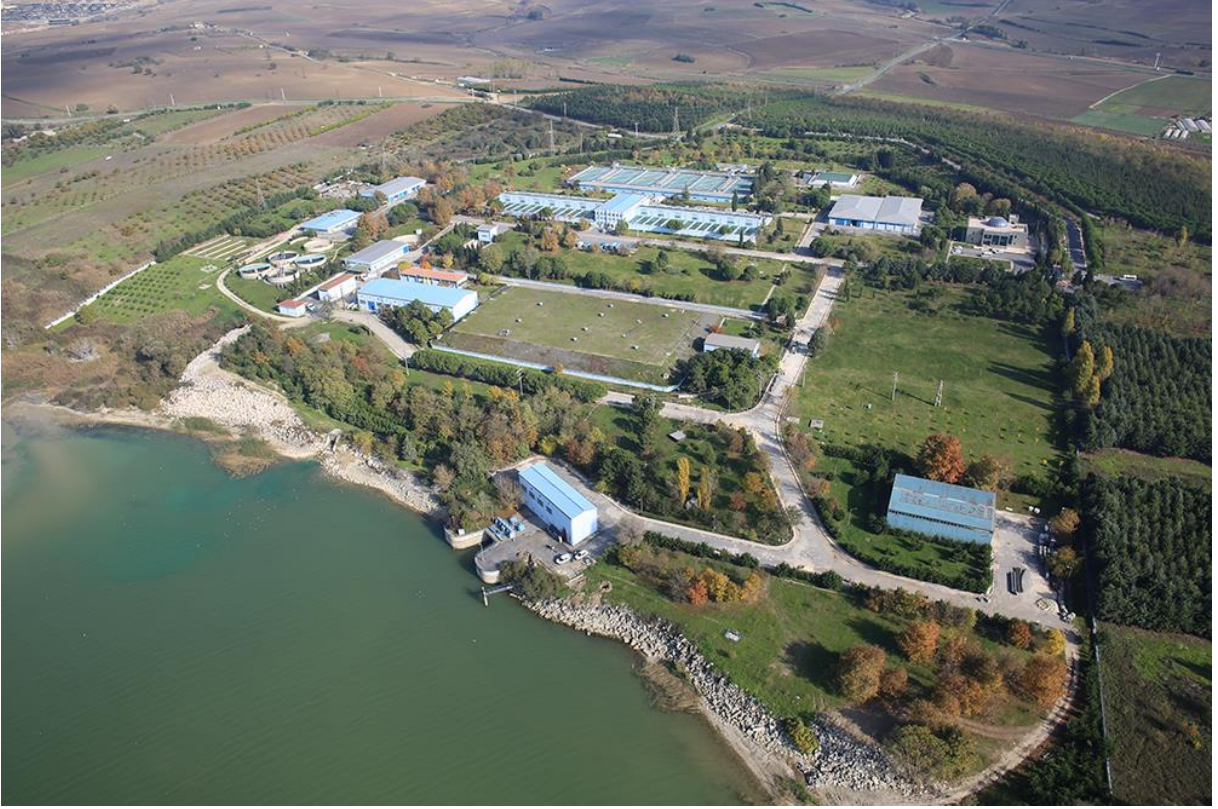
Şekil 7. Büyükçekmece İçme Suyu Arıtma Tesisi.
